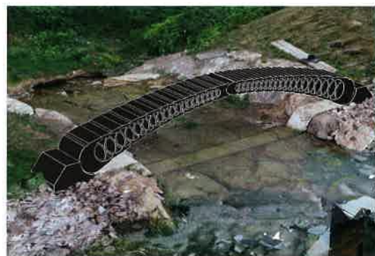
1 Podélný pohled na lávku osazenou na výpusti rybníka v Solopiscích 2 Tvarování tiskové dráhy 3 Tisk lávky v Kloknerově ústavu trval cca 6 h 4 Zatěžovací zkouška lávky 5 Vizualizace osazení lávky – příčný práh výpusti rybníka nahradil spodní táhlo trojúhelníkové konstrukce 6 Finální návrh 3D tištěné lávky 7 Osazování lávky na hrázi rybníka
